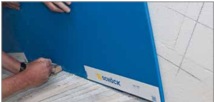
Abb. 124: Unteres Laufprofil von Tronsole® Typ L anzeichnen
