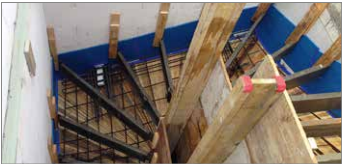
Abb. 130: Treppenlauf bewehren und Stufenbretter anbringen
