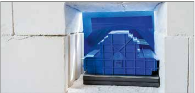
Abb. 49: Wandaussparung vergießen
