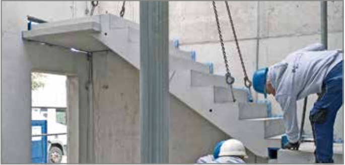
Abb. 54: Treppenlauf positionieren
