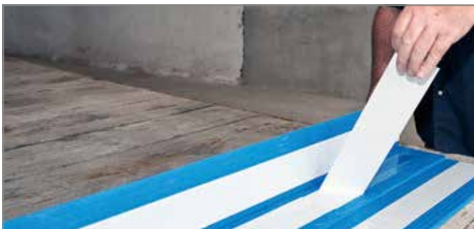
Abb. 104: Schutzfolie von Tronsole® Typ F abziehen
