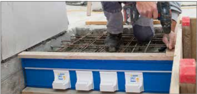
Abb. 92: Tronsole® Typ T abstützen
