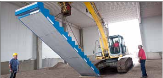
Abb. 143: Vorbereitete Treppe einsetzen
