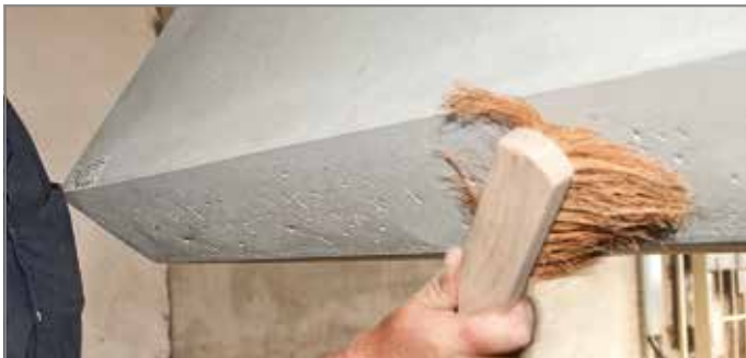
Abb. 102: Staub und lose Teile entfernen
