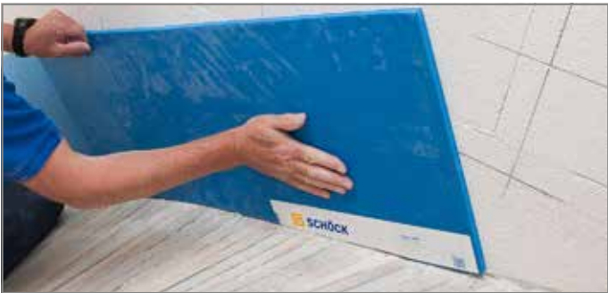
Abb. 129: Tronsole® Typ L aufkleben
