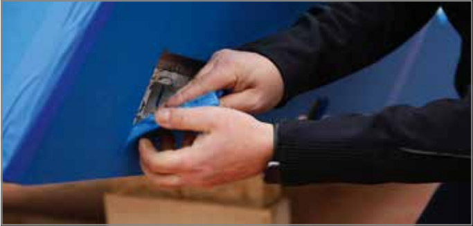
Abb. 75: Ausschnitt für die Brandschutzmanschette entfernen
