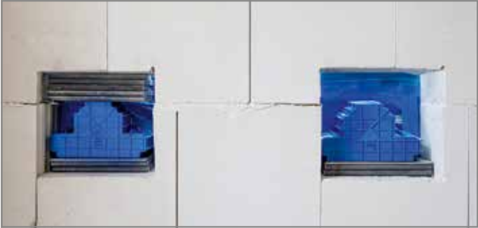
Abb. 45: Wandelement abkleben. Einstellung von Höhe und gegebenenfalls abhebender Kräfte mittels Ausgleichsplatten
