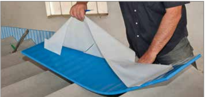
Abb. 137: Im Bereich des Treppenlaufs Schutzfolie von Tronsole® Typ L abziehen
