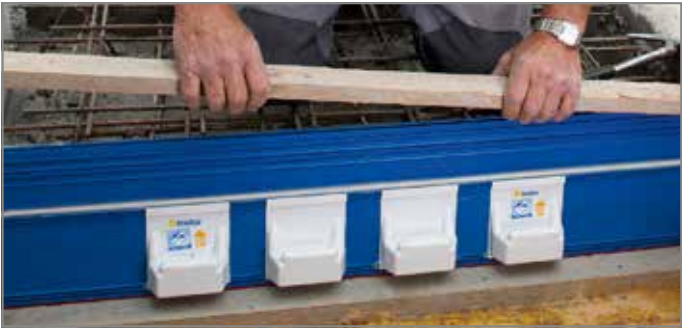
Abb. 91: Obere Nagelleiste in Tronsole® Typ T einklipsen
