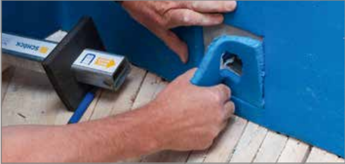
Abb. 65: Ausschnitt für die Brandschutzmanschette entfernen
