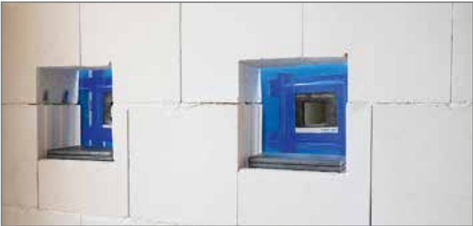
Abb. 39: Podest auf Höhe der Wandaussparungen positionieren
