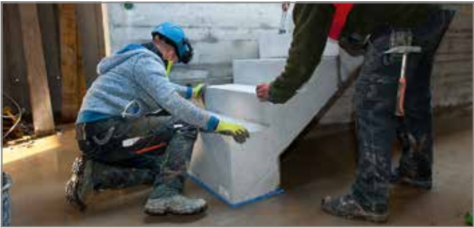
Abb. 121: Treppe absetzen
