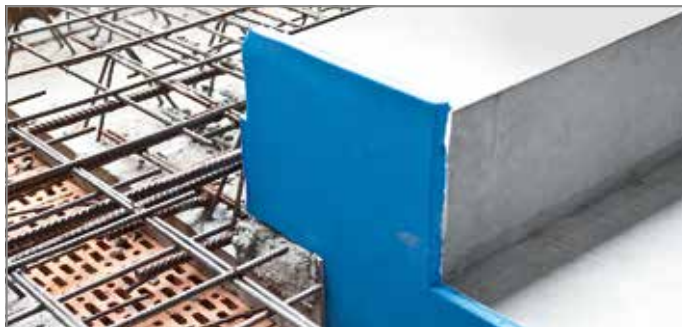
Abb. 144: Oberes Auflager der Treppe kontrollieren
