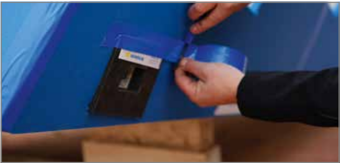
Abb. 76: Brandschutzmanschette einsetzen und abkleben
