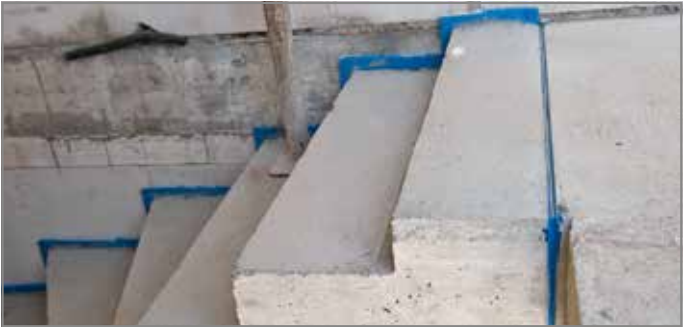
Abb. 134: Gerade Fugenausbildung am Treppenaustritt
