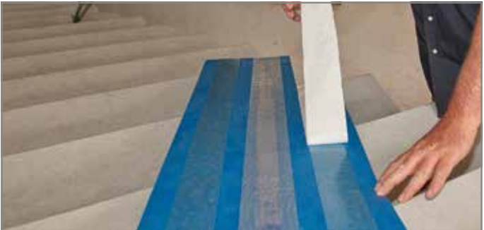
Abb. 109: Schutzfolie von Tronsole® Typ B abziehen
