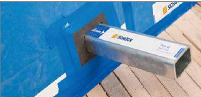
Abb. 67: Traglelement montieren und Brandschutzmanschette abkleben
