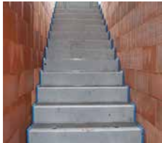
Abb. 7: Die blaue Linie zeigt den schallbrückenfreien Einbau als Qualitätsmerkmal für einen sicheren Schallschutz.
