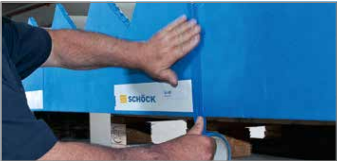
Abb. 142: Stöße von Tronsole® Typ L verkleben
