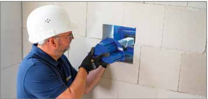
Abb. 43: Tragelement und Wandelement in Podesthülse einfahren
