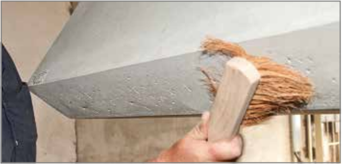
Abb. 108: Staub und lose Teile entfernen
