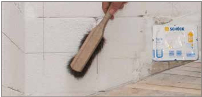
Abb. 123: Staub und lose Teile entfernen
