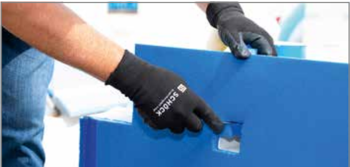
Abb. 34: Geometrie der Podesthülse ausschneiden
