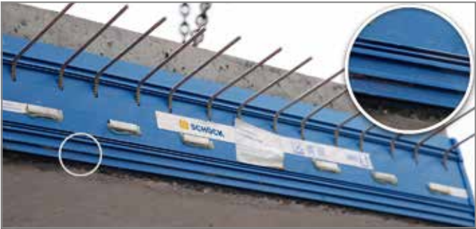
Abb. 101: Nagelleiste unbedingt entfernen
