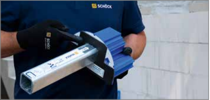
Abb. 42: Tragelement bis zum Anschlag in Wandelement einfahren
