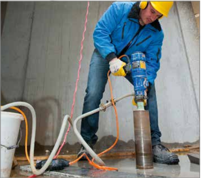
Abb. 114: Kernbohrung mit 100 mm Durchmesser in Bodenplatte setzen
