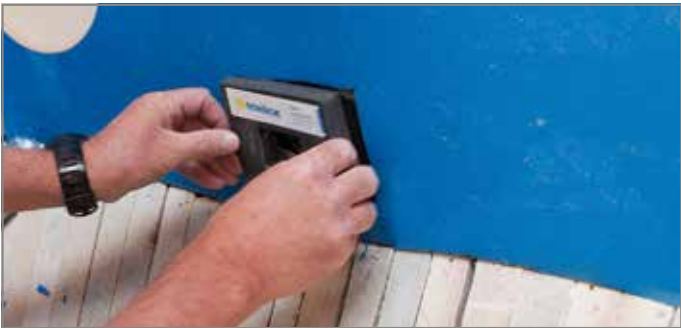
Abb. 66: Brandschutzmanschette einsetzen
