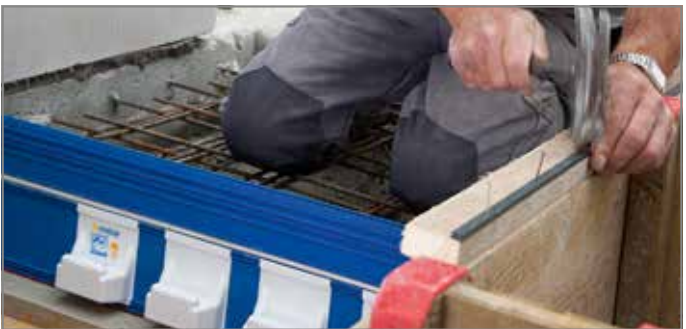
Abb. 90: Obere Nagelleiste anbringen
