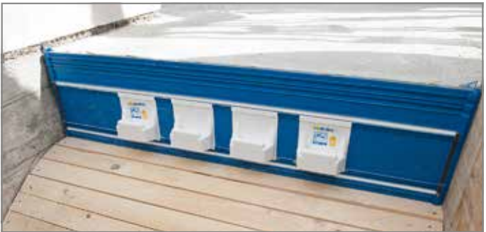
Abb. 95: Oberer Anschluss mit Tronsole® Typ T
