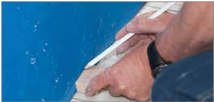
Abb. 125: Unteres Laufprofil von Tronsole® Typ L anzeichnen
