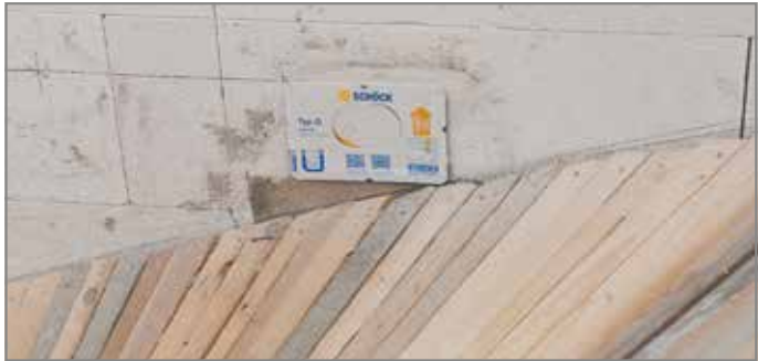
Abb. 59: Wandelement Tronsole® Typ Q in KS-Wand eingemauert
