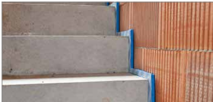
Abb. 145: Überstand der Fugenplatte kontrollieren
