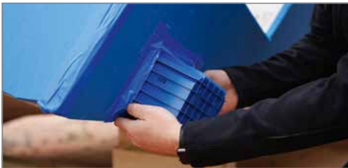
Abb. 80: Wandelement für Einbauzustand waagerecht ausrichten und abkleben
