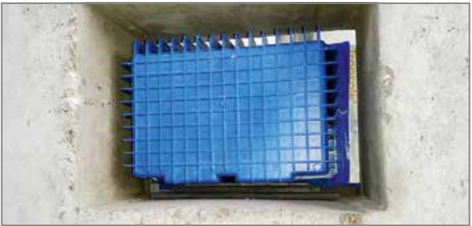
Abb. 55: Höheneinstellung Tronsole® Typ Z vollständig und kraftschlüssig mit druckfesten Unterlegplatten vornehmen
