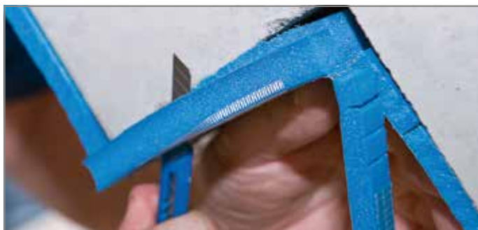
Abb. 106: Tronsole® Typ F bündig mit der Treppe zuschneiden
