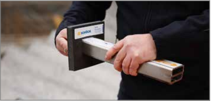
Abb. 72: Bei Brandschutzanforderung R 90 Brandschutzmanschette auf Tragelement aufstecken
