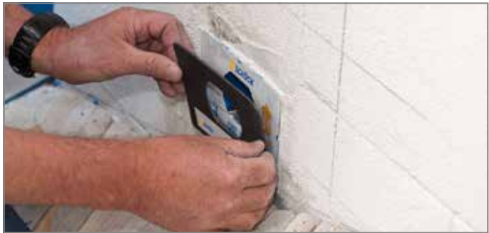
Abb. 61: Brandschutzabdeckung aufkleben
